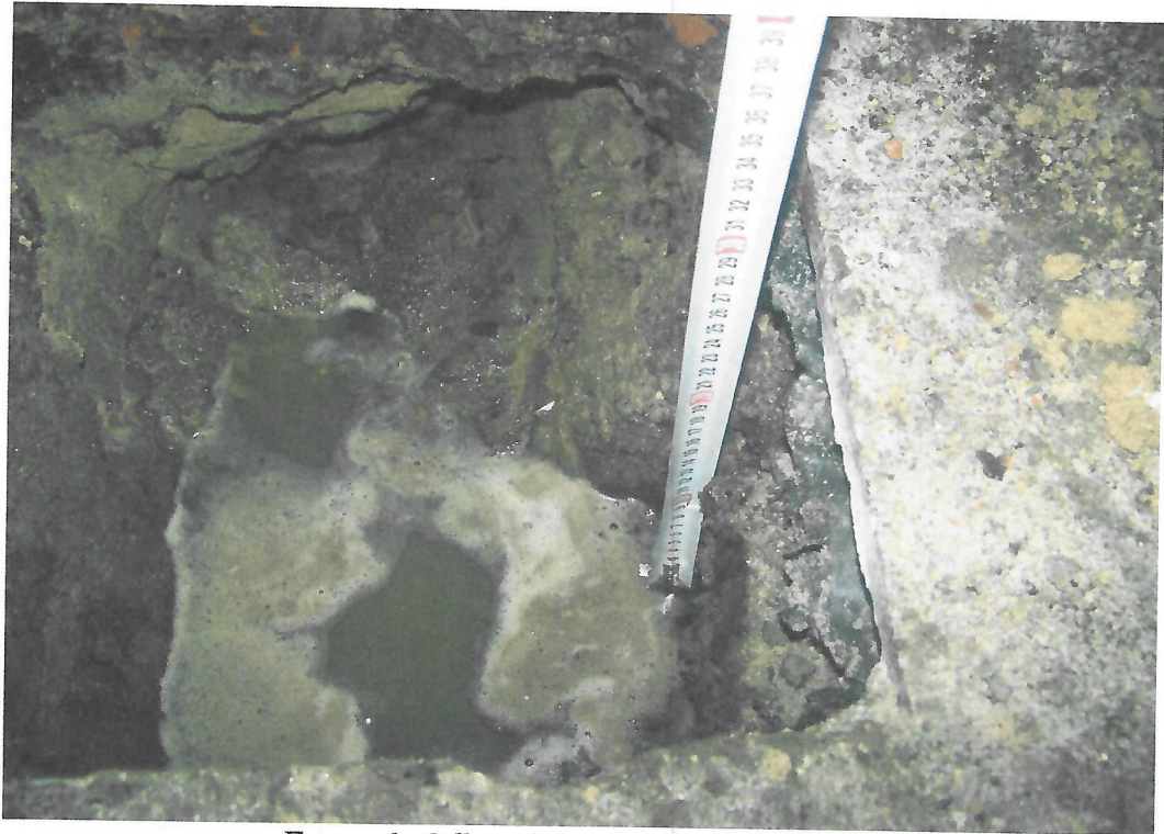
Fot. nr 9 Odkrywka nr 2-od strony piwnicy
