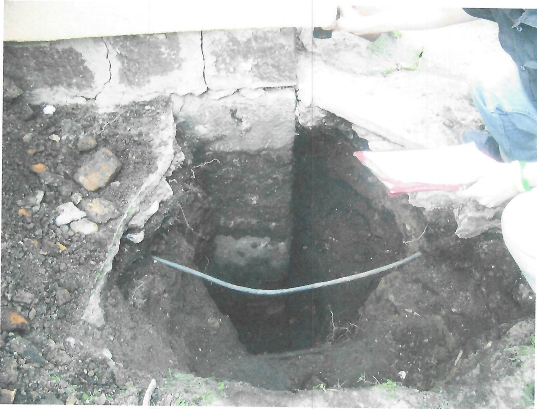
Fot. nr 5 Odkrywka nr 1 od zewnątrz
