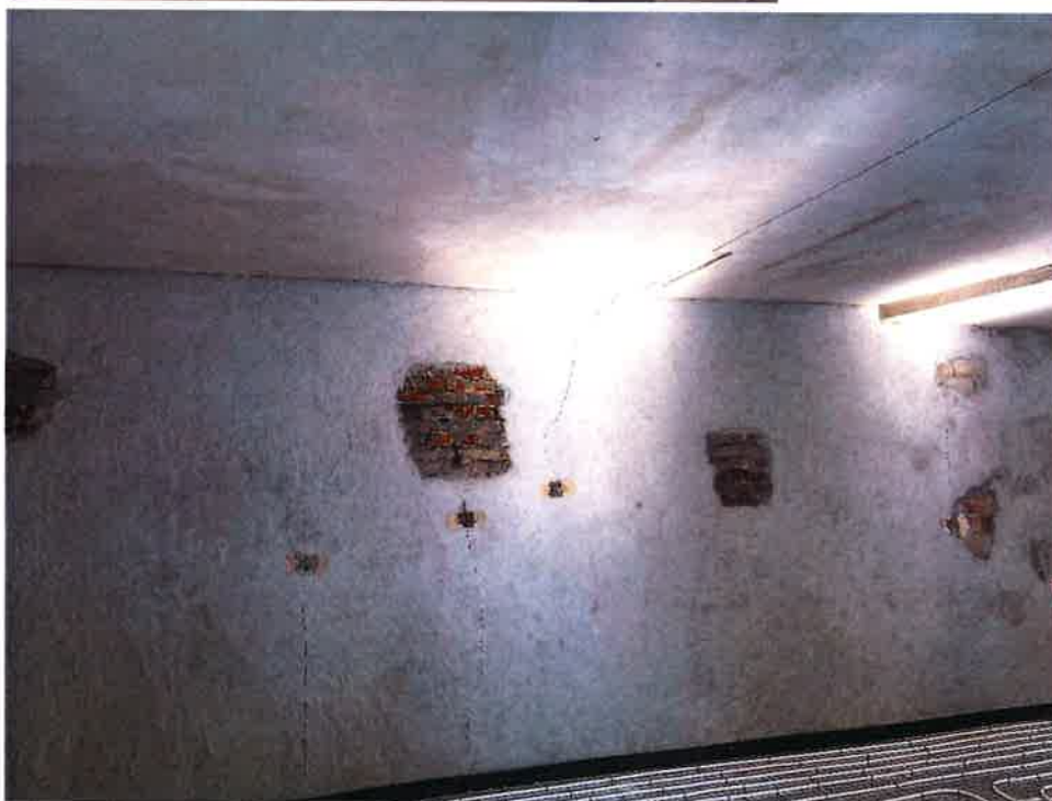
Zdj. 1. Pęknięcie w północno-wschodnim narożniku.
