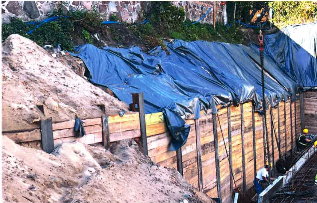
Zdj. 13 Widok zachodniej strony wykonanej obudowy
