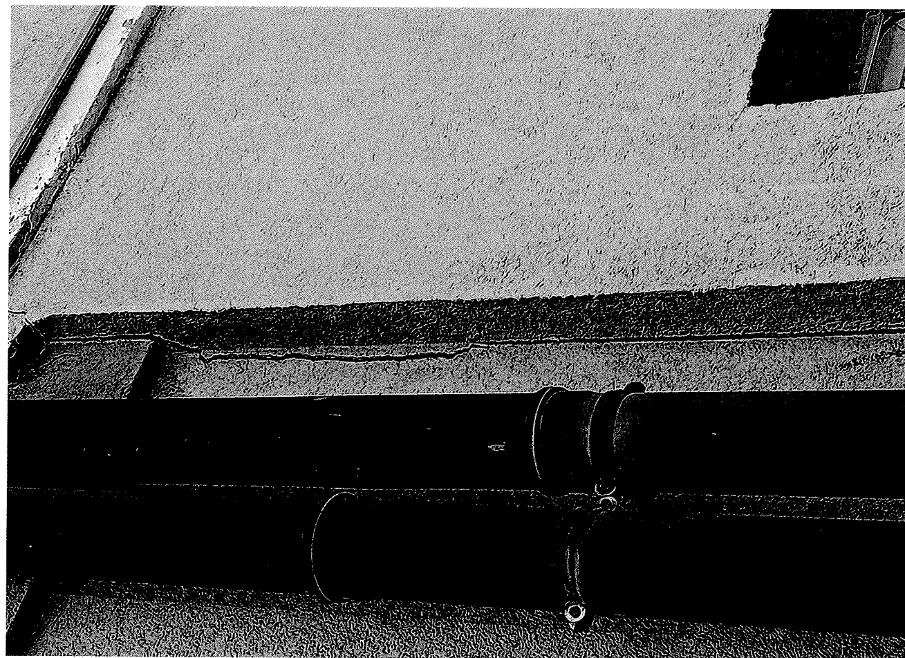
ELEWACJA BUDYNKU (RYŚĆ POSZERZONA)
