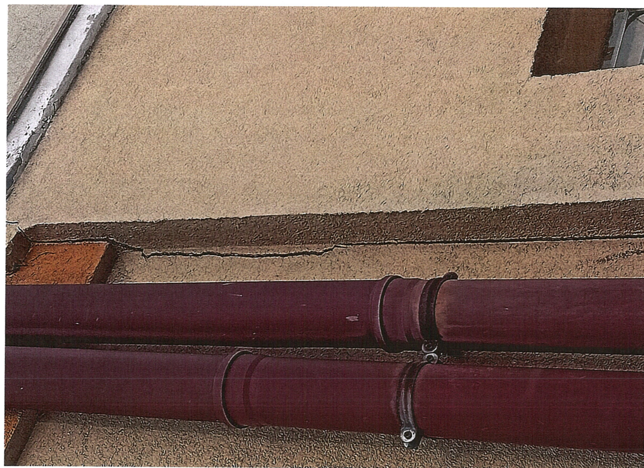
ELEWACJA BUDYNKU (RYŚĆ POSZERZONA)
