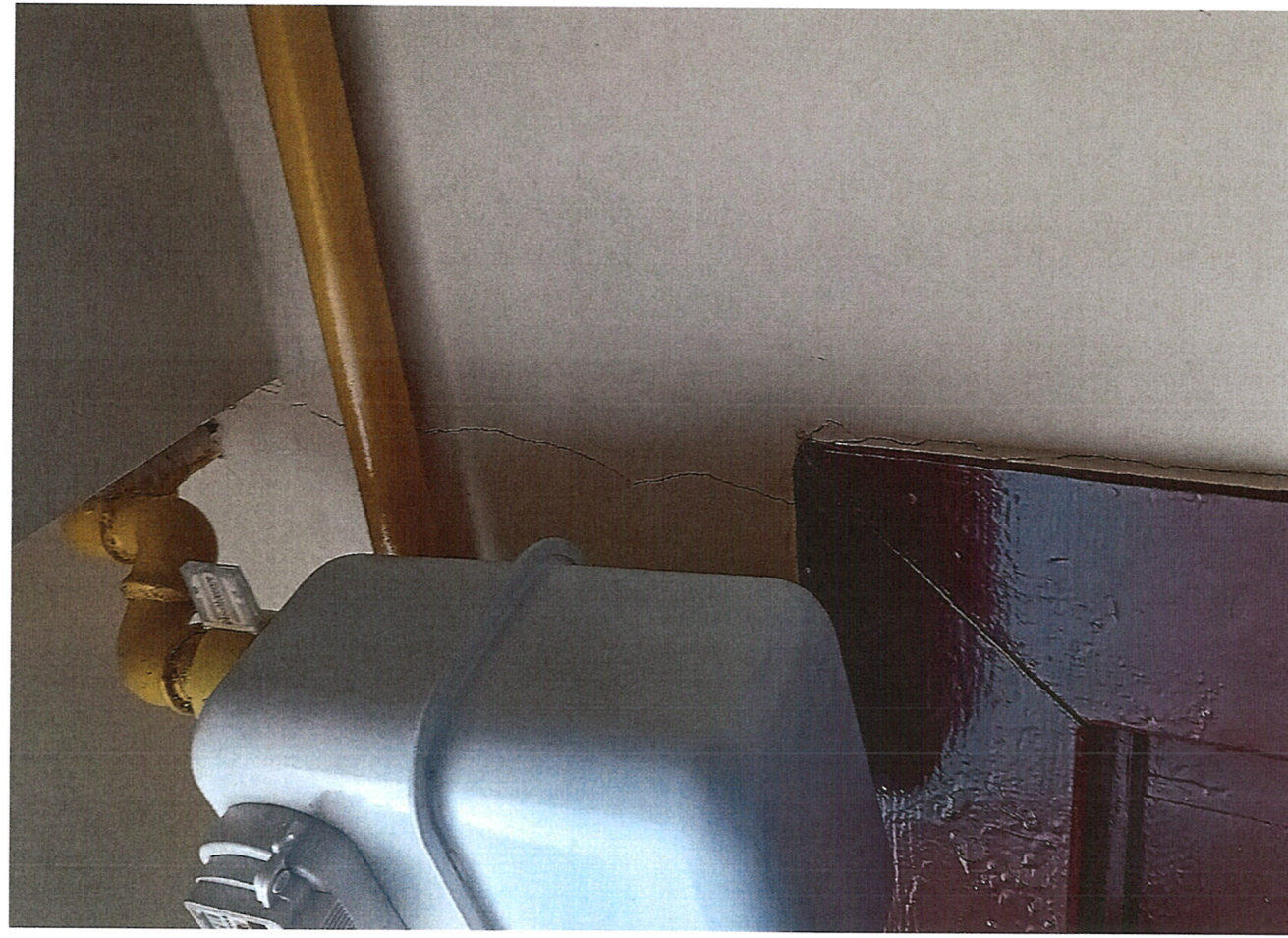
KUŁTKA SCHODOWA - PĘKNIĘCIA W CZĘŚCI ODDALONEJ OD PLACU BUDOWY (NOWE)
